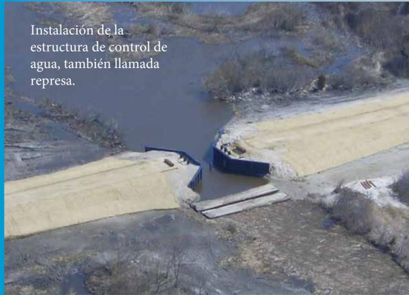
Instalación de la estructura de control de agua, también llamada represa.
