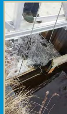
Al agregar tablonces se retiene el agua río arriba y eleva el nivel del agua en un lado.
