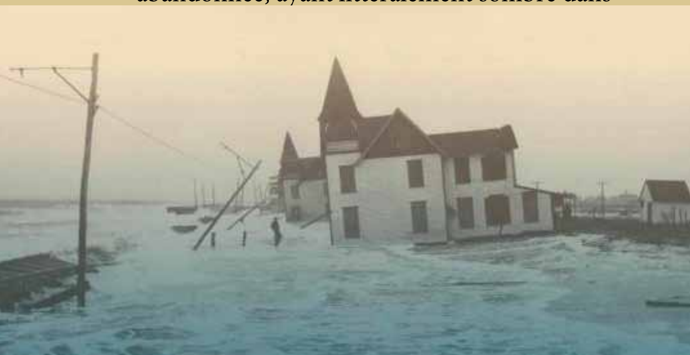
Les dégâts causés par les tempêtes aux habitations et aux entreprises ont été importants
