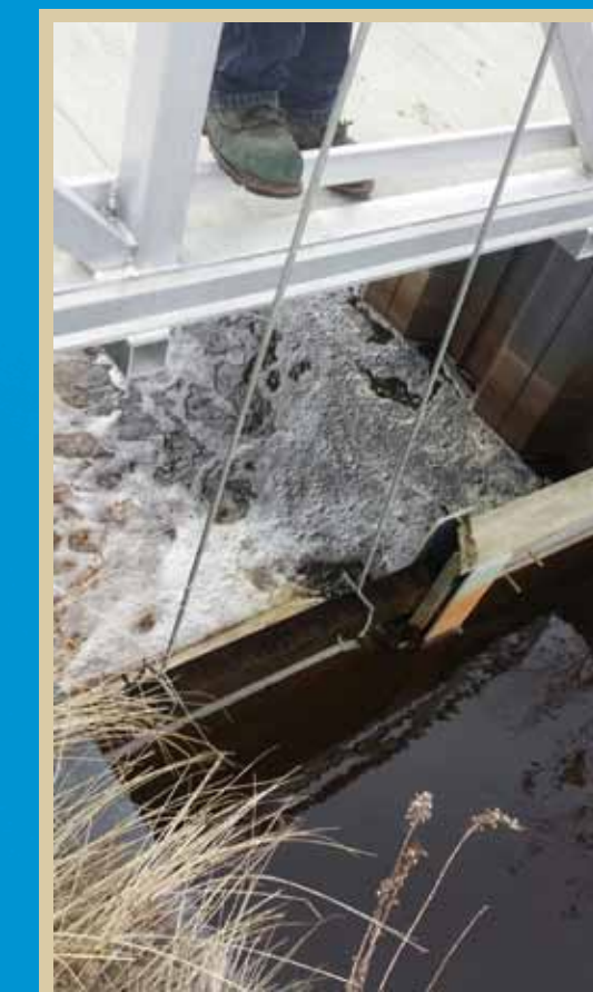
Al agregar tablonces se retiene el agua río arriba y eleva el nivel del agua en un lado.
