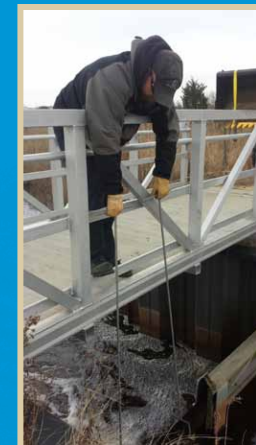
Usamos dos ganchos especiales para agregar o quitar tablonces.
