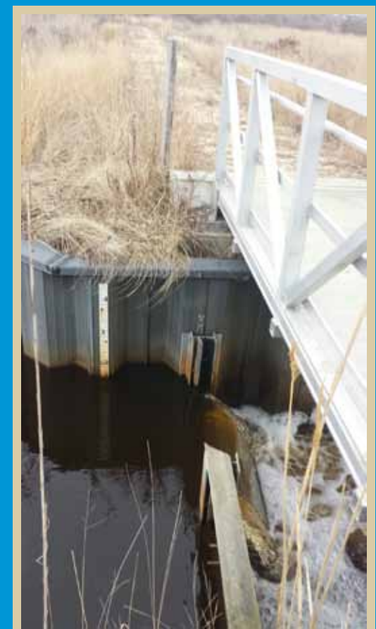
Remover tablonces permite que el agua se drene de un estanque al siguiente.
