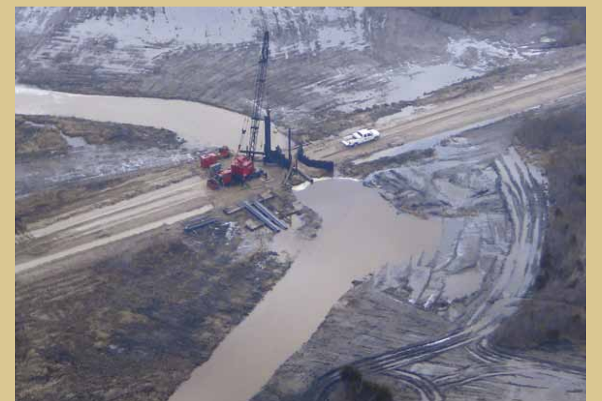
Instalación de uno de los sistemas de control de agua, o represas
